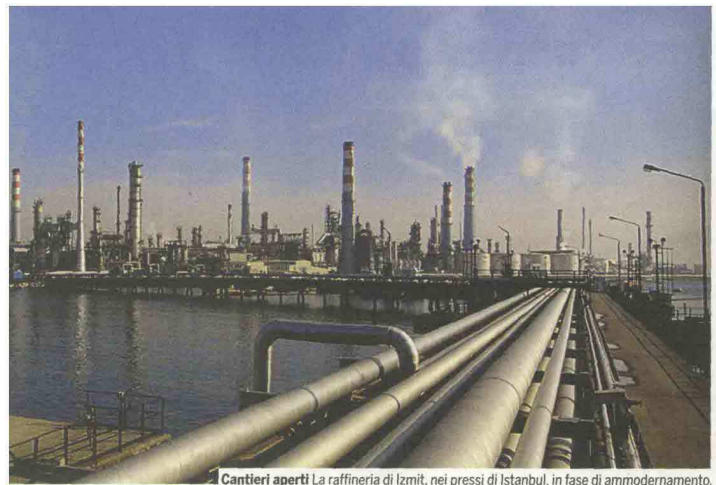
Cantieri aperti La raffineria di Izmit, nei pressi di Istanbul, in fase di ammodernamento.
